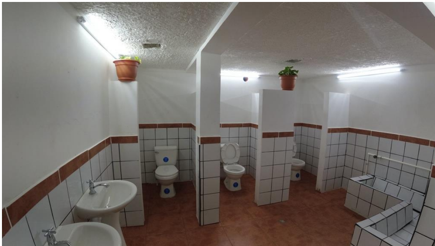
Fast fertig erstellte Sanitäranlage
